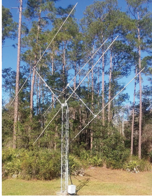
N9HF 4xFO16 222 MHz EME Array
